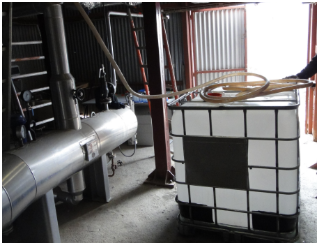
(a) Preparación del depósito
