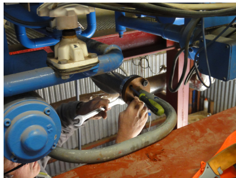
(d) Instalación de los caudalímetros
