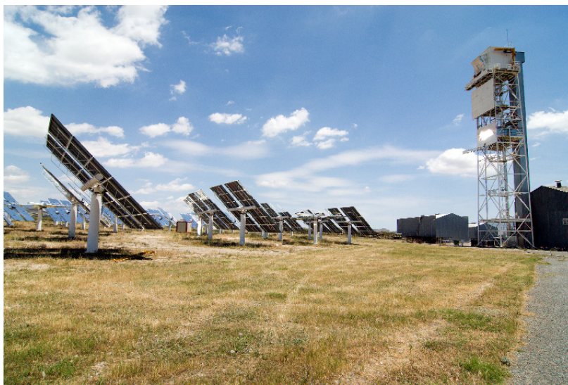
(a) Vista general de la instalación
